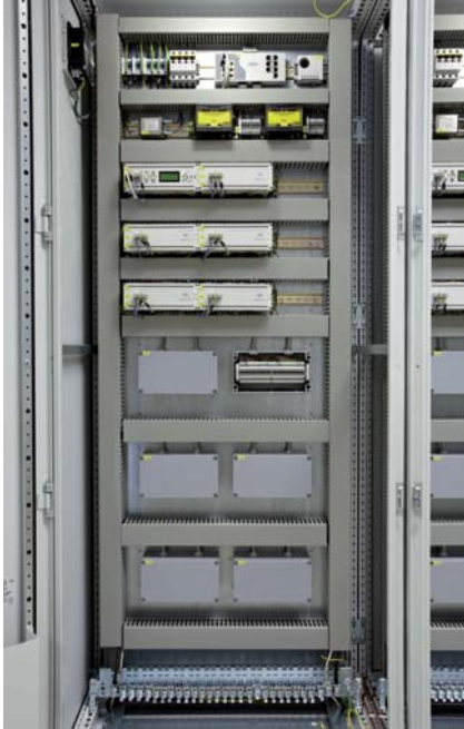
Bild 2 | Die Befestigung des Systems im Schaltschrank erfolgt auf der Hutschiene.
