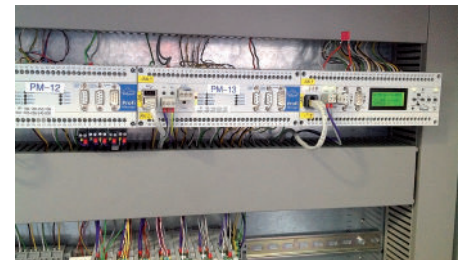
02 Die ProfiMessage-Geräte übernehmen heute die Überwachung aller Parameter
