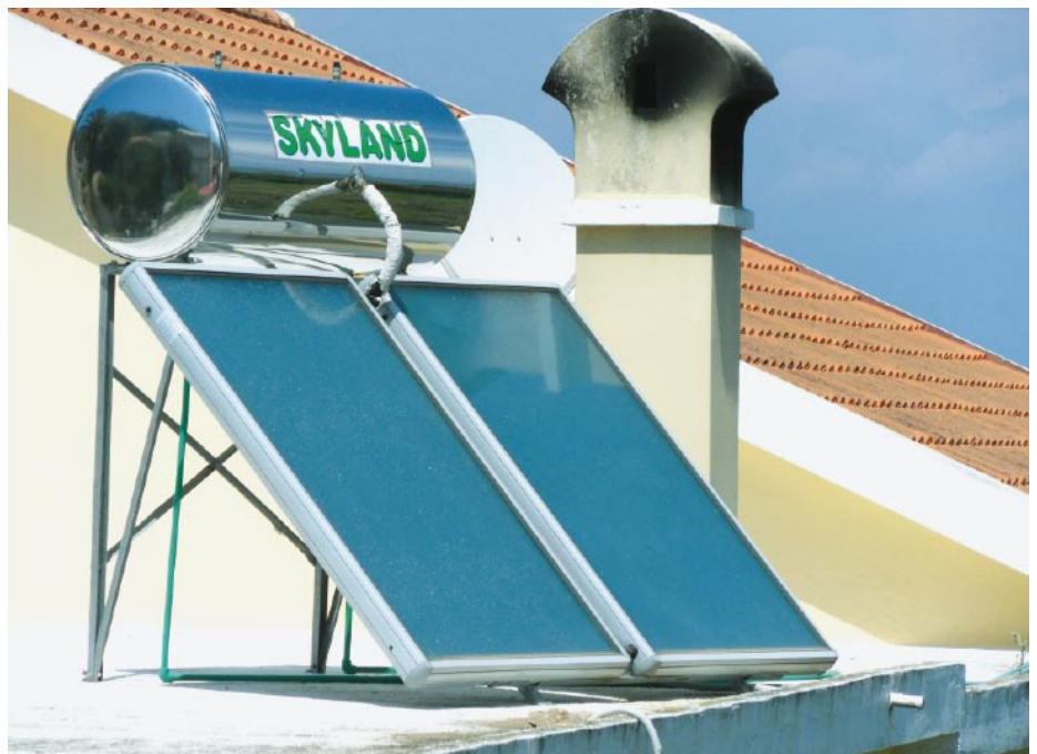
Abb. 2: Der Wasserbehälter einer Thermosiphon-Anlage befindet sich oberhalb des Kollektors (Bild: Hochschule Ingolstadt)
