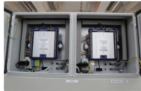
Jeweils zwei Expert Key-Geräte pro Waschmaschinen-Brücke können Wassertemperatur und -verbrauch von bis zu 16 Maschinen aufzeichnen.
