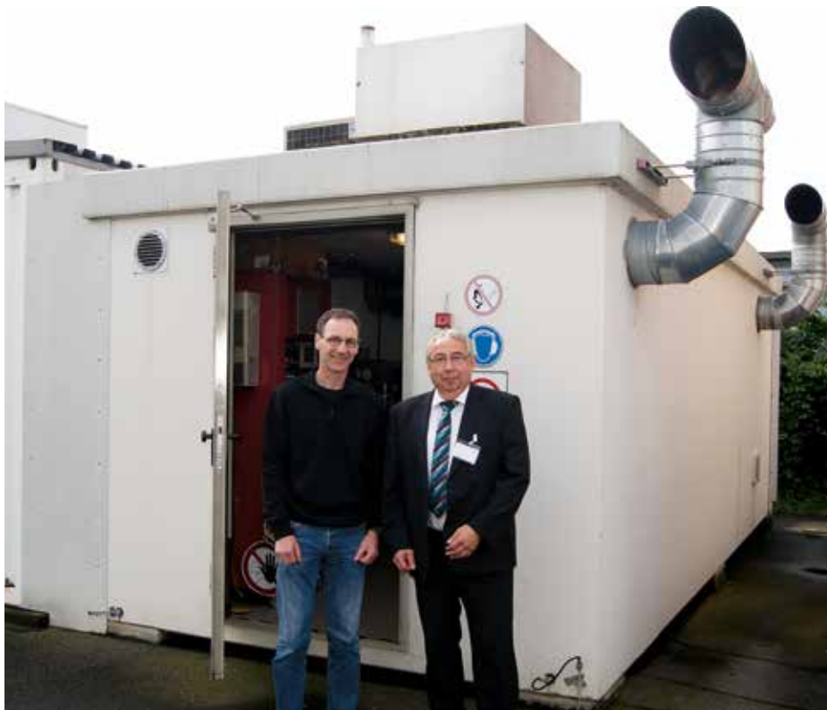
01 Dipl.-Ing. (FH) Dieter Jöckel, Test Engineer bei der Norma-Group (links), und Dipl.-Ing. Dietmar Scheider, Senior Sales Manager bei Delphin Technology, vor dem Container mit dem Heißgasprüfstand
